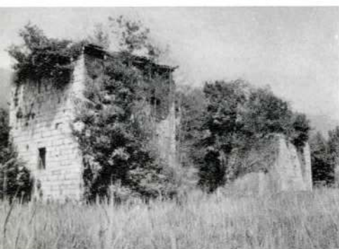
Les tours sud-est vues des anciens fossés.
