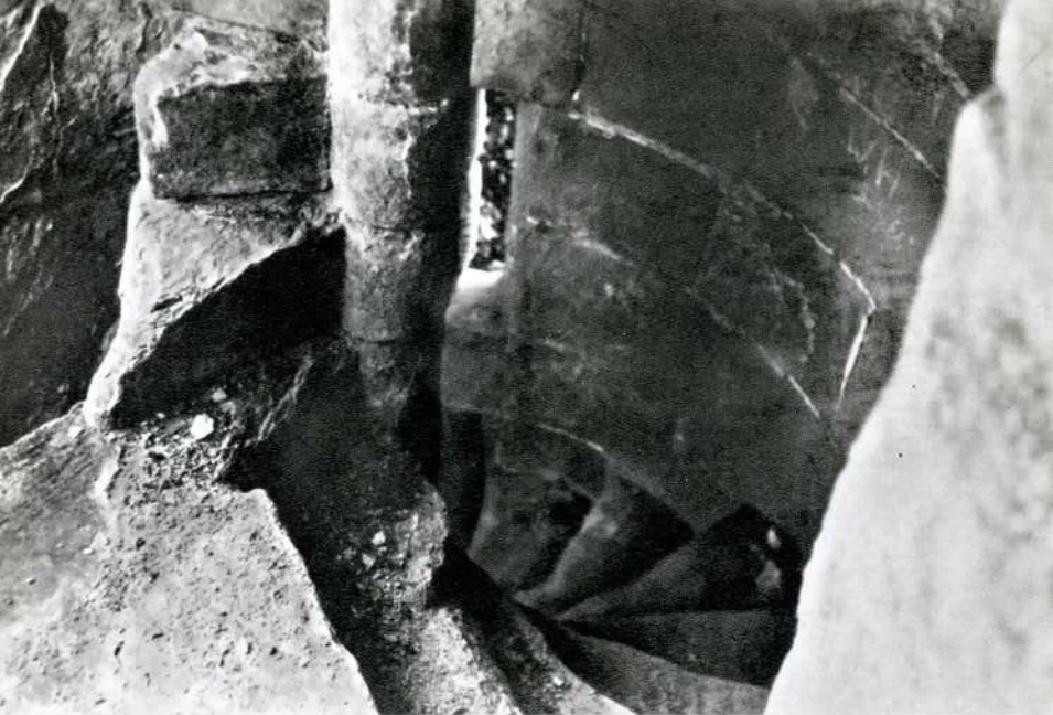
Escaliers du donjon nord-ouest. (Cl. Lovie)
